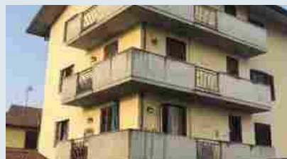
Appartamenti Caselle Lurani Santa Maria Nascente
