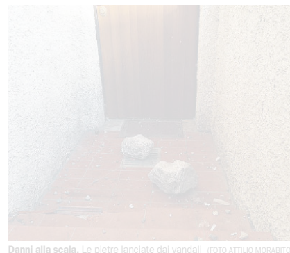
Danni alla scala. Le pietre lanciate dai vandali (FOTO ATTILIO MORABITO)
